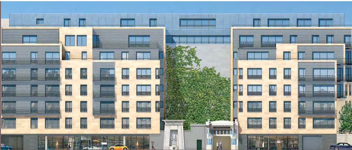
Cimaise végétale mettant en valeur la fontaine du Fellah et la station de métro "art déco" Vaneau.
