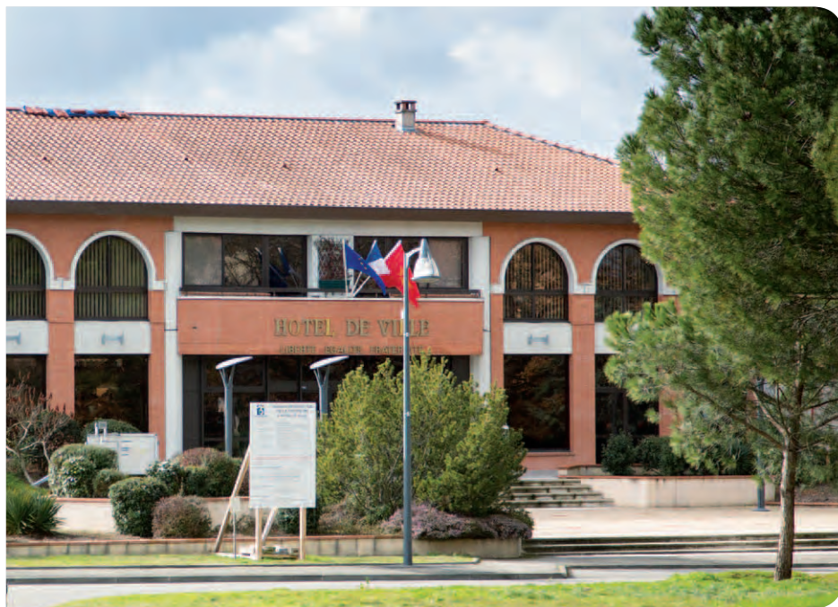
L'Hôtel de ville de Balma, à proximité du parc de Lagarde © VINCI Immobilier
